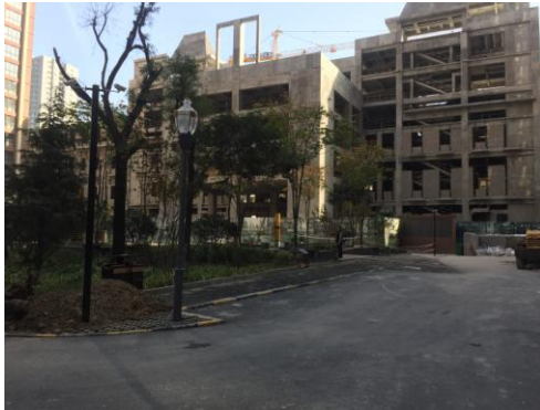
项目西侧在建四海唐人街项目
