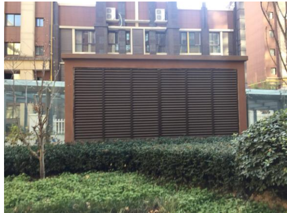
项目地下车库排风口
